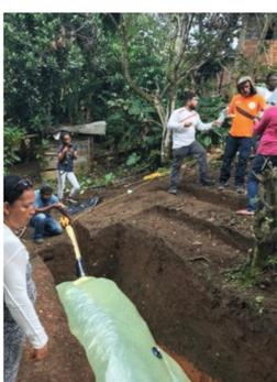
Se han instalado, por parte de la comunidad, dos biodigestores para la generación de gas a partir de excrementos y residuos. Foto: Renata Moreno. UAO.
